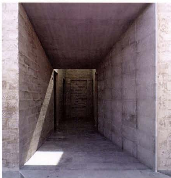
A SINISTRA: DETTAGLIO DI UNO DEI DUE PROFONDI VESTIBOLI CHE SI APRONO SULLA FACCIATA PRINCIPALE. OGNI VESTIBOLO DÀ ACCESSO A QUATTRO CAMERE ED È ILLUMINATO DA UN LUCERNARIO. IN BASSO: VEDUTA DA NORD-EST.
