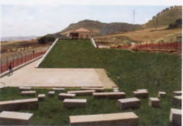
16 GIARDINO ARENA Architect: Marco Navarra Completed: 2004 Address: Stazione ferroviaria di San Michele di Ganzaria, Caltagirone
